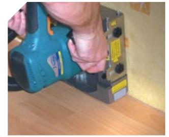
Corte de la junta de dilatación.
